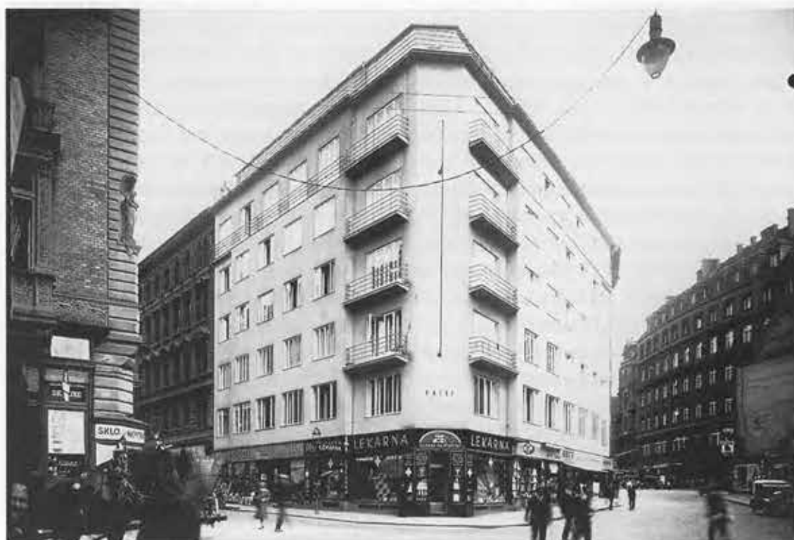
4. Nároží Perštýna a Skořepky po dokončení novostavby
