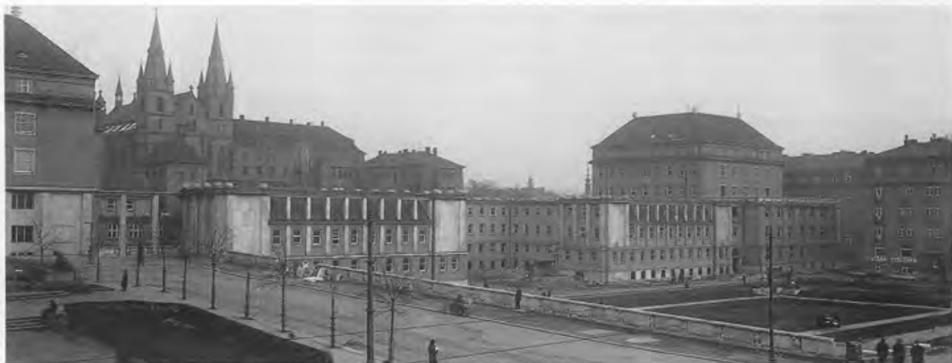
2. Zástavba pod Emauzy podle projektu arch. B. Hübschmanna, jeden z největších úspěchů Klubu
