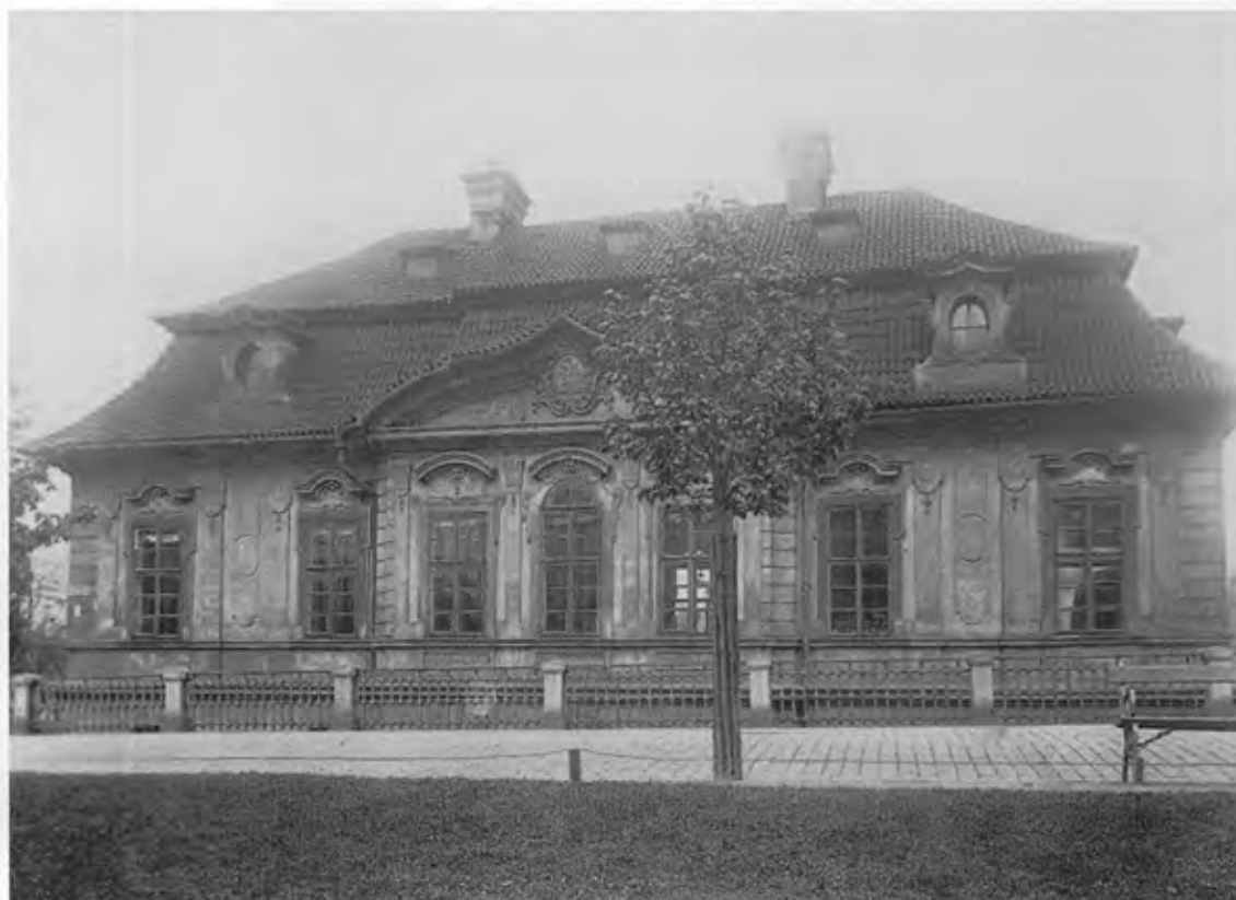
53. Průčelí Dientzenhoferova pavilonu od Smíchova po regulaci
