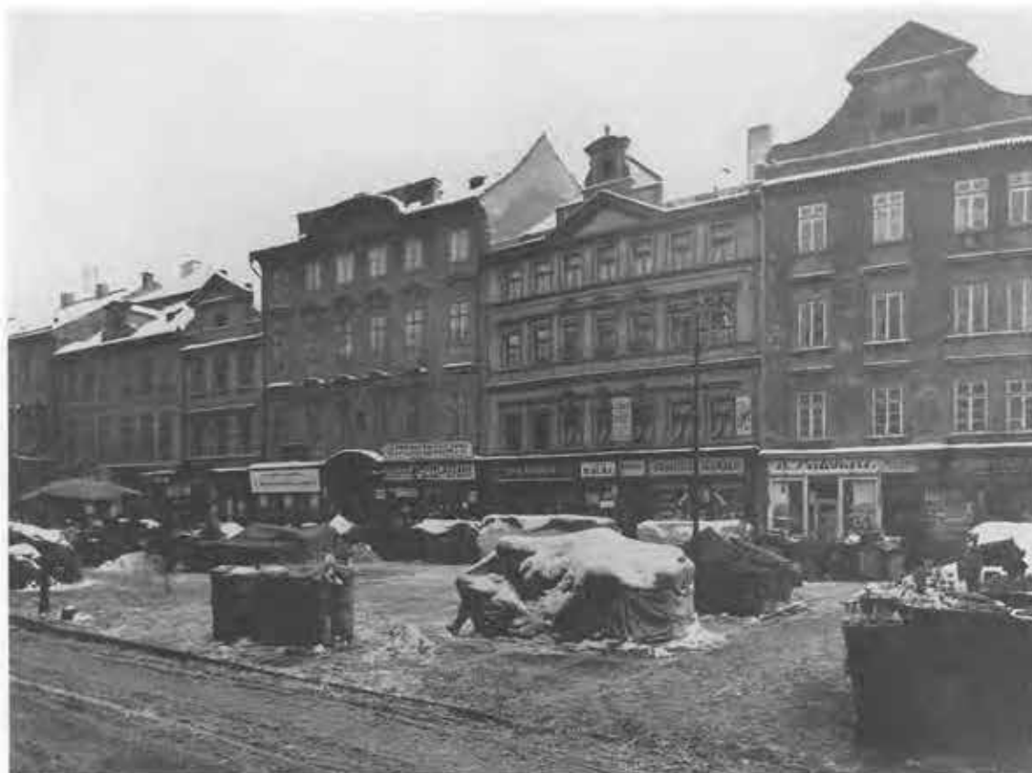
26. Historické domy na Ovocném trhu před demolicí
