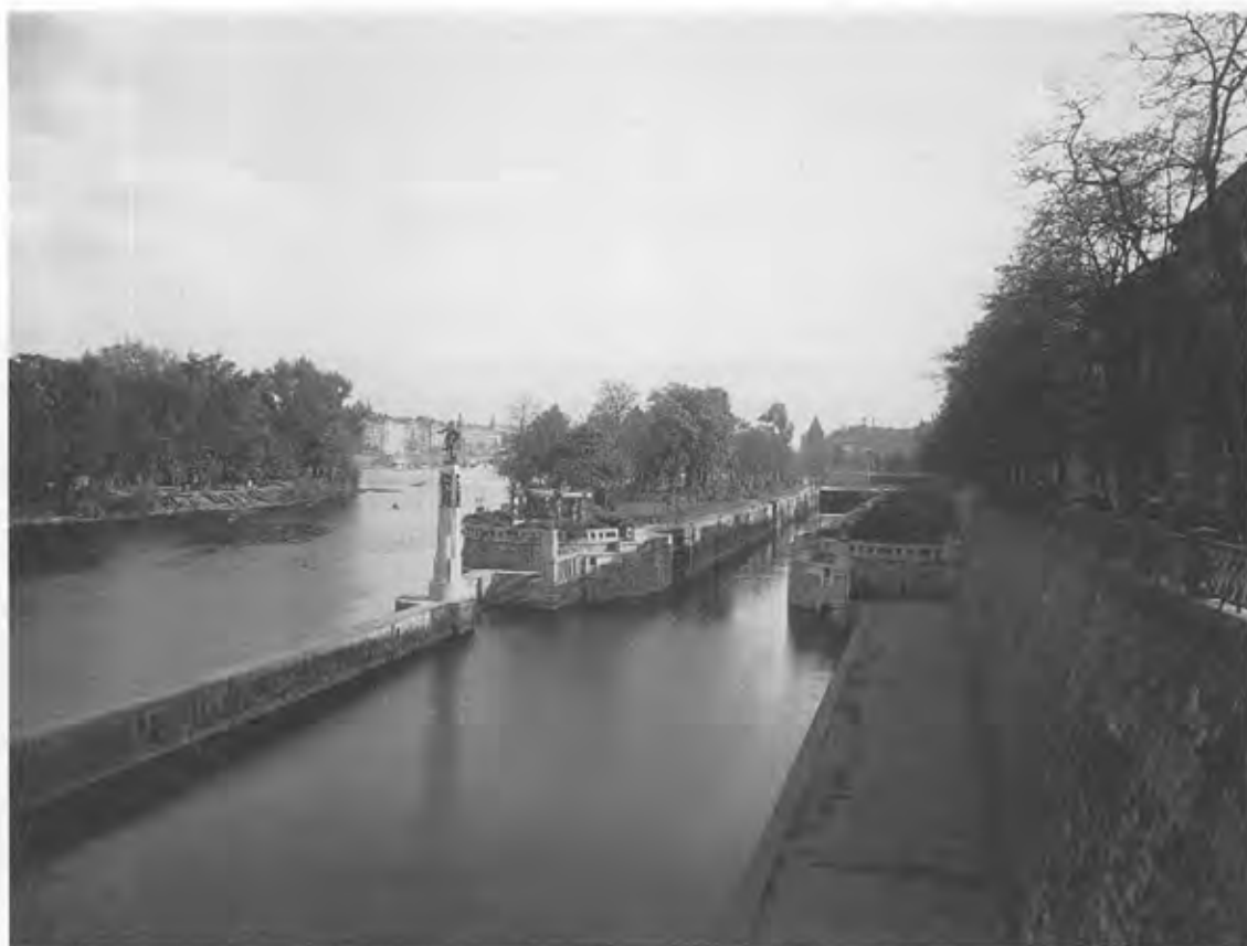
69. Realizovaná plavební komora u Židovského ostrova
