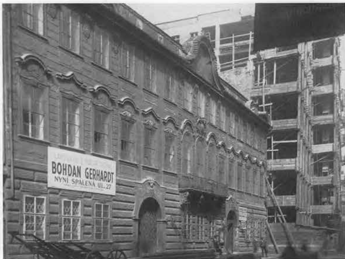
24. Pozdněbarokní palác Thun-Salmů v Jungmannově ulici před demolicí
