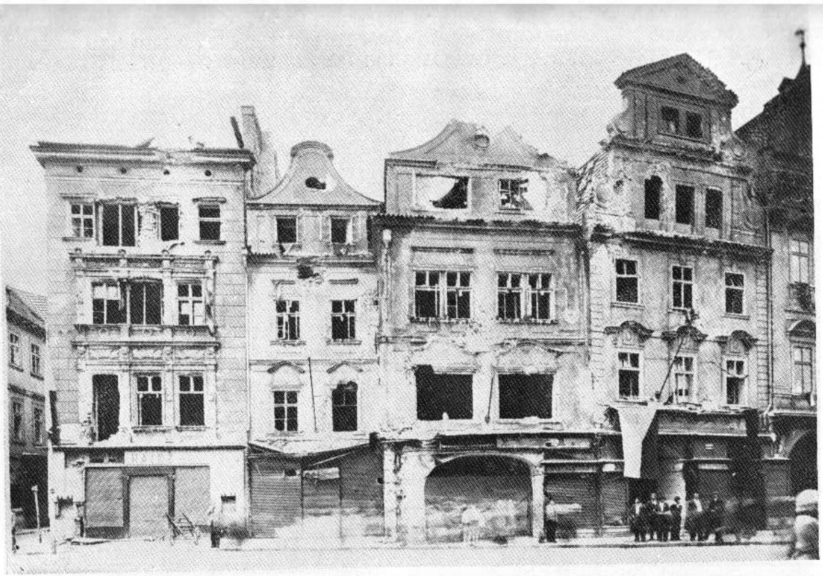
9 TOTÉŽ U DOMŮ PROTI ORLOJI. TŘETÍ ROK PO ZKÁZE NECHÁVÁME RYNK PUSTNOUT A NEVIDÍME NEBEZPEČÍ V PRŮTAHU A CHCEME ZAMEZIT OHROŽOVÁNÍ BEZPEČNOSTI OKAMŽITÝM ZBOURÁNÍM RADNICE. Str. 10.
