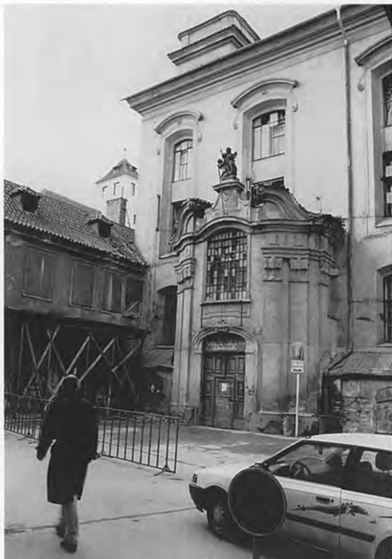
89. Průčelí kostela sv. Michala před započítím rekonstrukce. Foto M. Fokt, 1996
