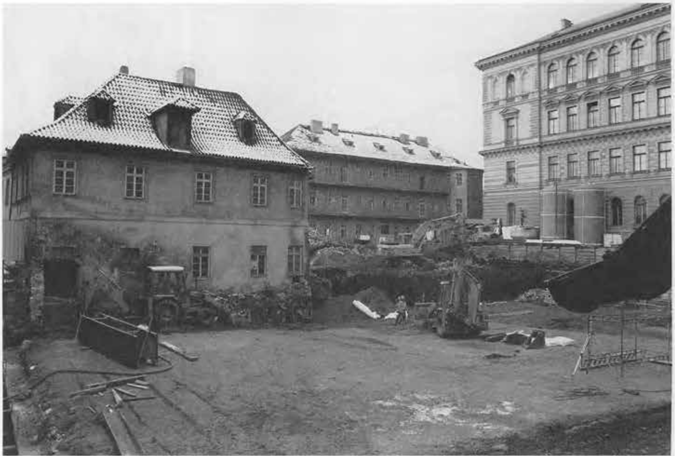
91. Staveniště budoucího hotelu Four Seasons s oběma památkově chráněnými domy v pohledu od Křížovnické ul. Foto M. Fokt, 1998
