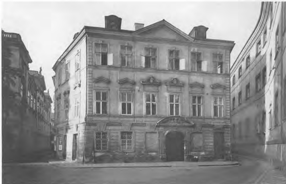
101. Hlavní průčelí Trautmannsdorfského paláce do Mariánského náměstí
