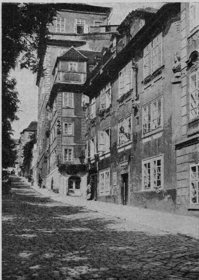
Dům »u kamenného sloupu« v Úvoze v Praze č. 160-IV.
