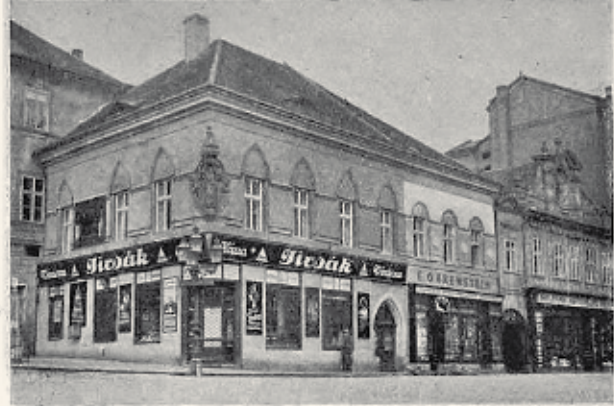
Obr. 6. Tentýž dům po nešťastné úpravě v r. 1925.
