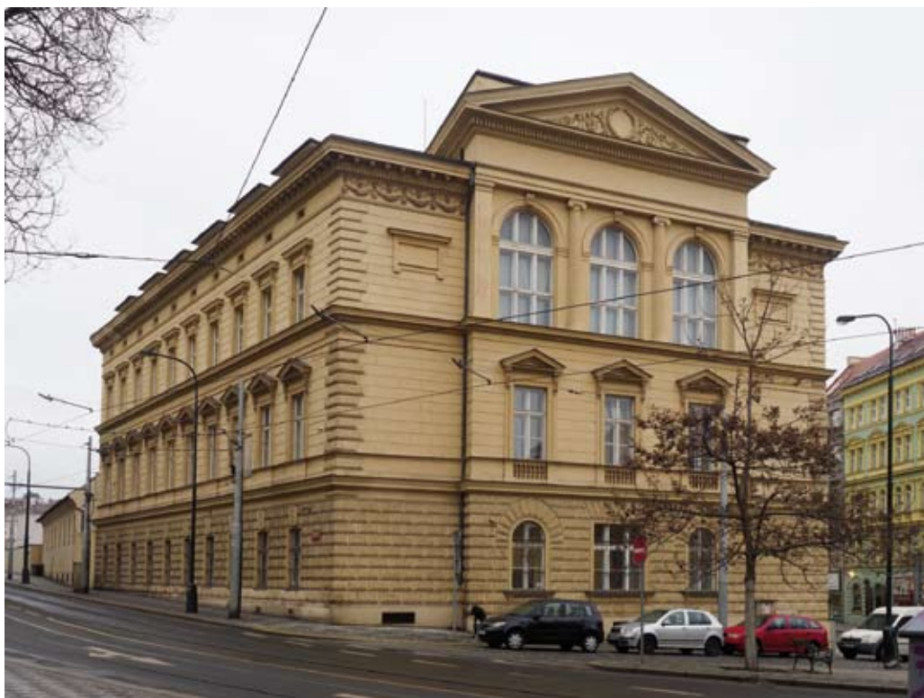
Budova bývalého chudobince u sv. Bartoloměje čp. 427-II. Foto: Pavla Vrbová, 2022.
