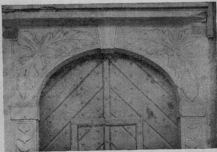
Portál zbořeného domu č. 23 na Mariánském náměstí.
