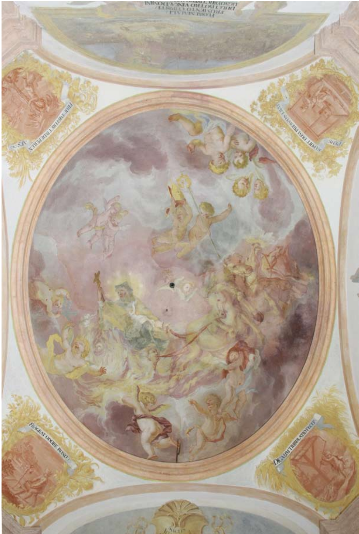
Celkový pohled na klenbu kaple sv. Jana Nepomuckého s nástropní malbou s výjevem Oslavení sv. Jana Nepomuckého. Stav po restaurování.
